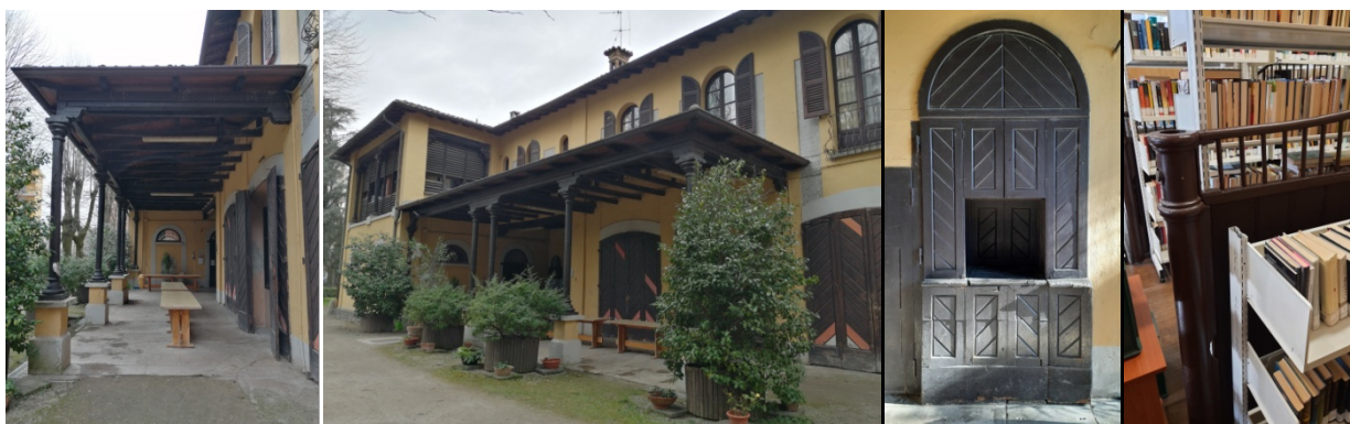
Particolare delle vecchie scuderie. Sono ancora presenti le divisioni in ferro e ghisa dei box dei cavalli
