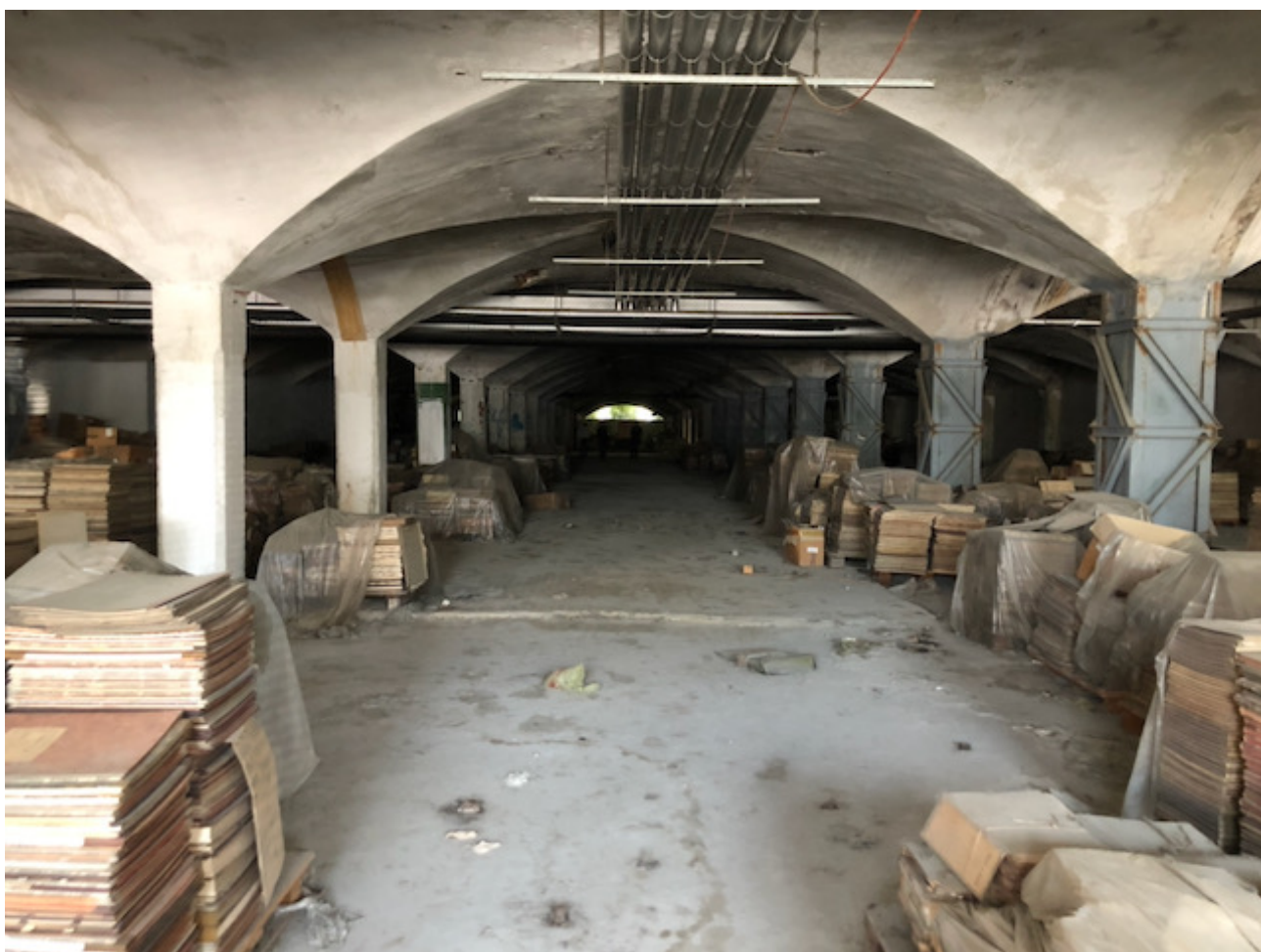
INTERNO DEL FUTURO ARCHIVIO STORICO
