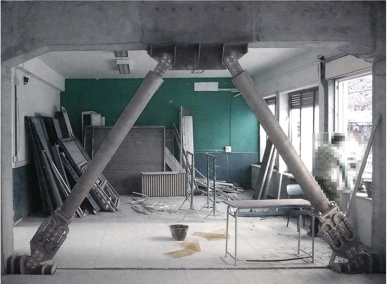
Installazione di controventi dissipativi
