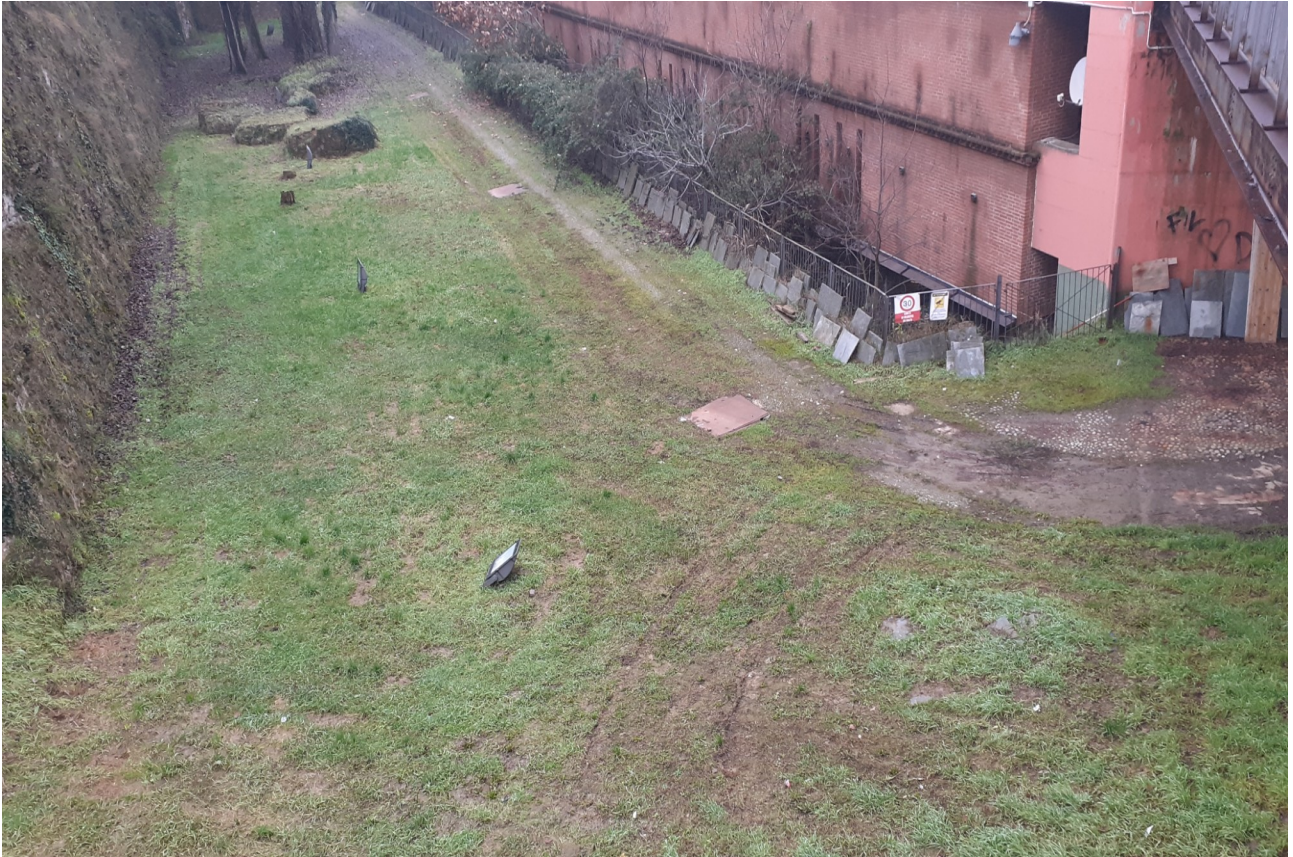
FOTO 5_fossato e mura (oggetto di restauro)
