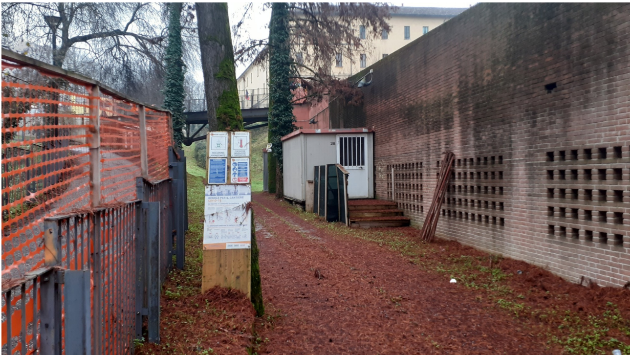
FOTO 10_ingresso al cantiere delle mura
