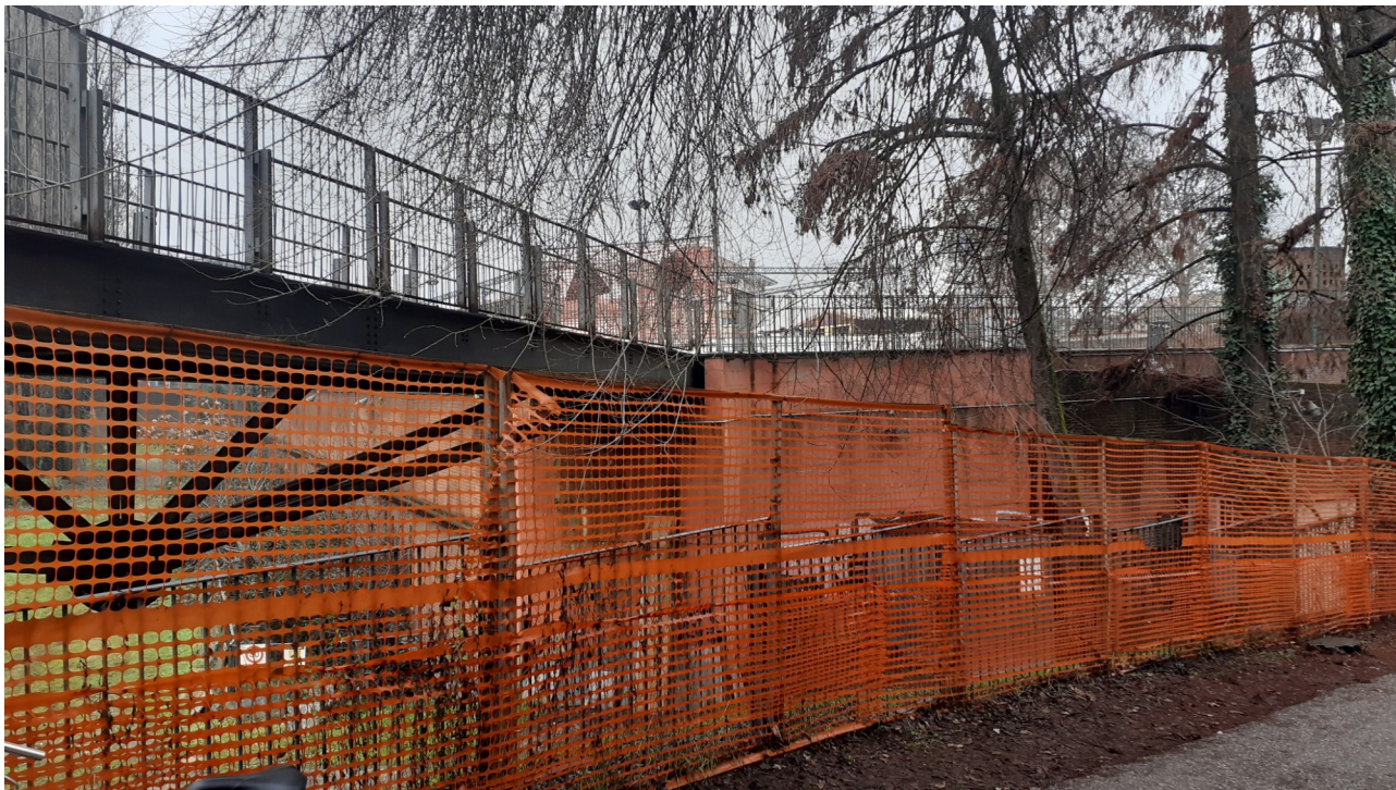
FOTO 7_vista della rampa
