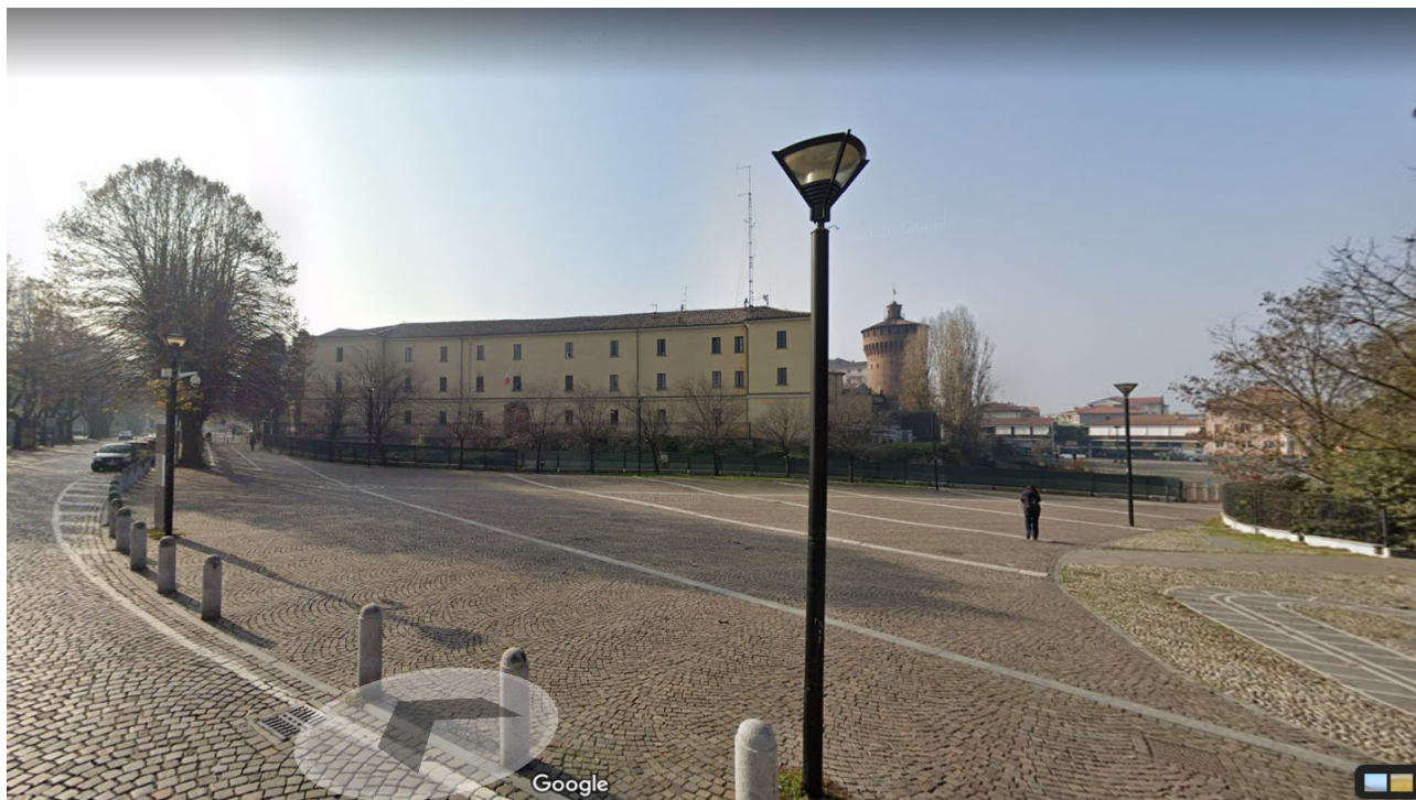
FOTO 1_ingresso in prossimità di via del Guasto
