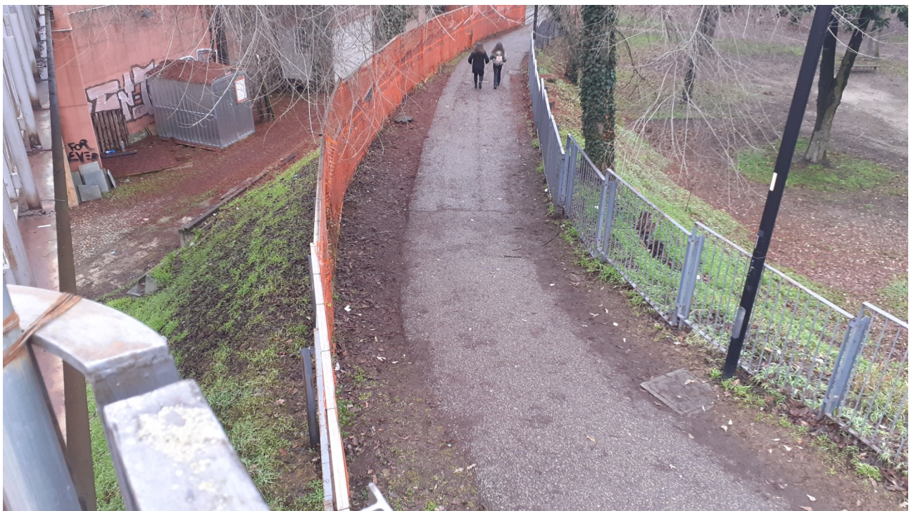
FOTO 6_vista della rampa
