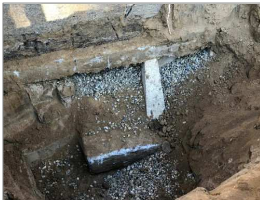
Fig. 7 - Base pilastro di fondazione della palestra
