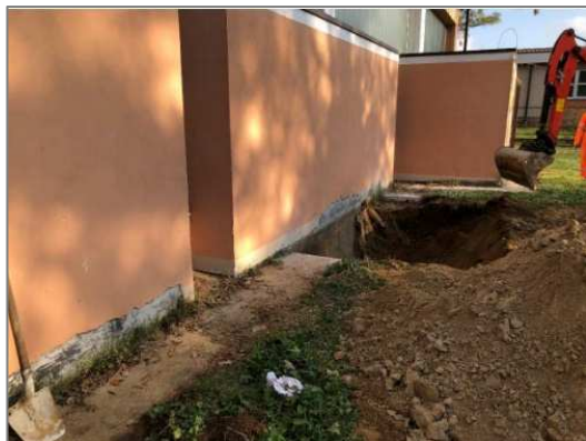
Fig. 6 - Sondaggio sulle fondazioni della palestra
