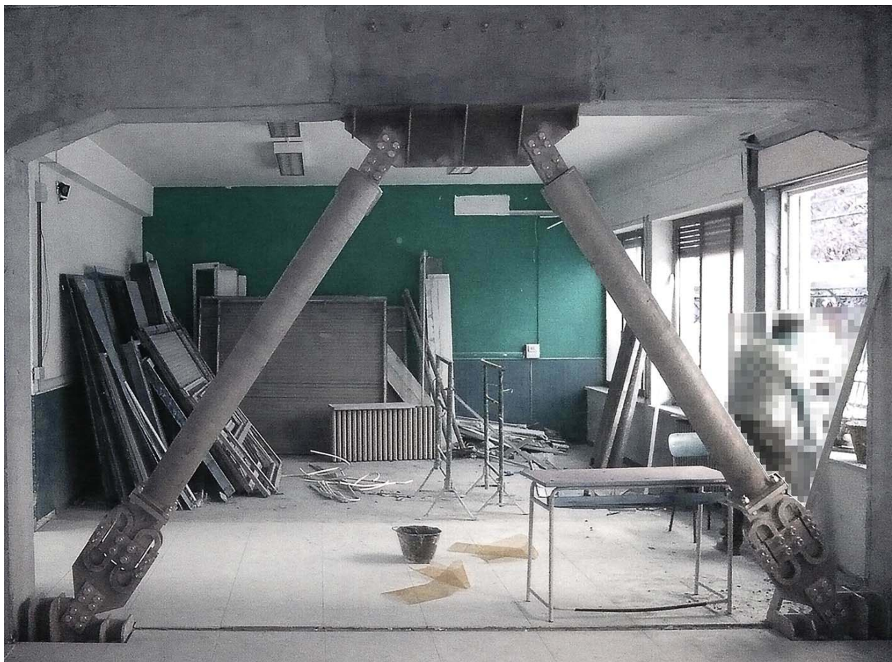
Installazione di controventi dissipativi
