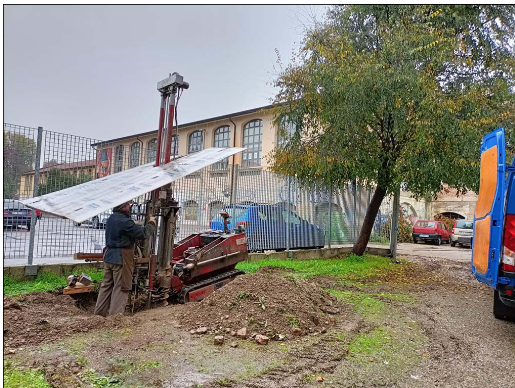
Foto 6-Prova penetrometrica statica CPT1
