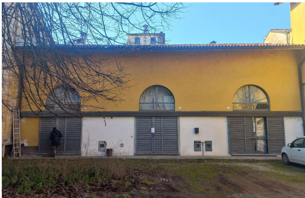
Accessi agli alloggi dalla corte interna.
