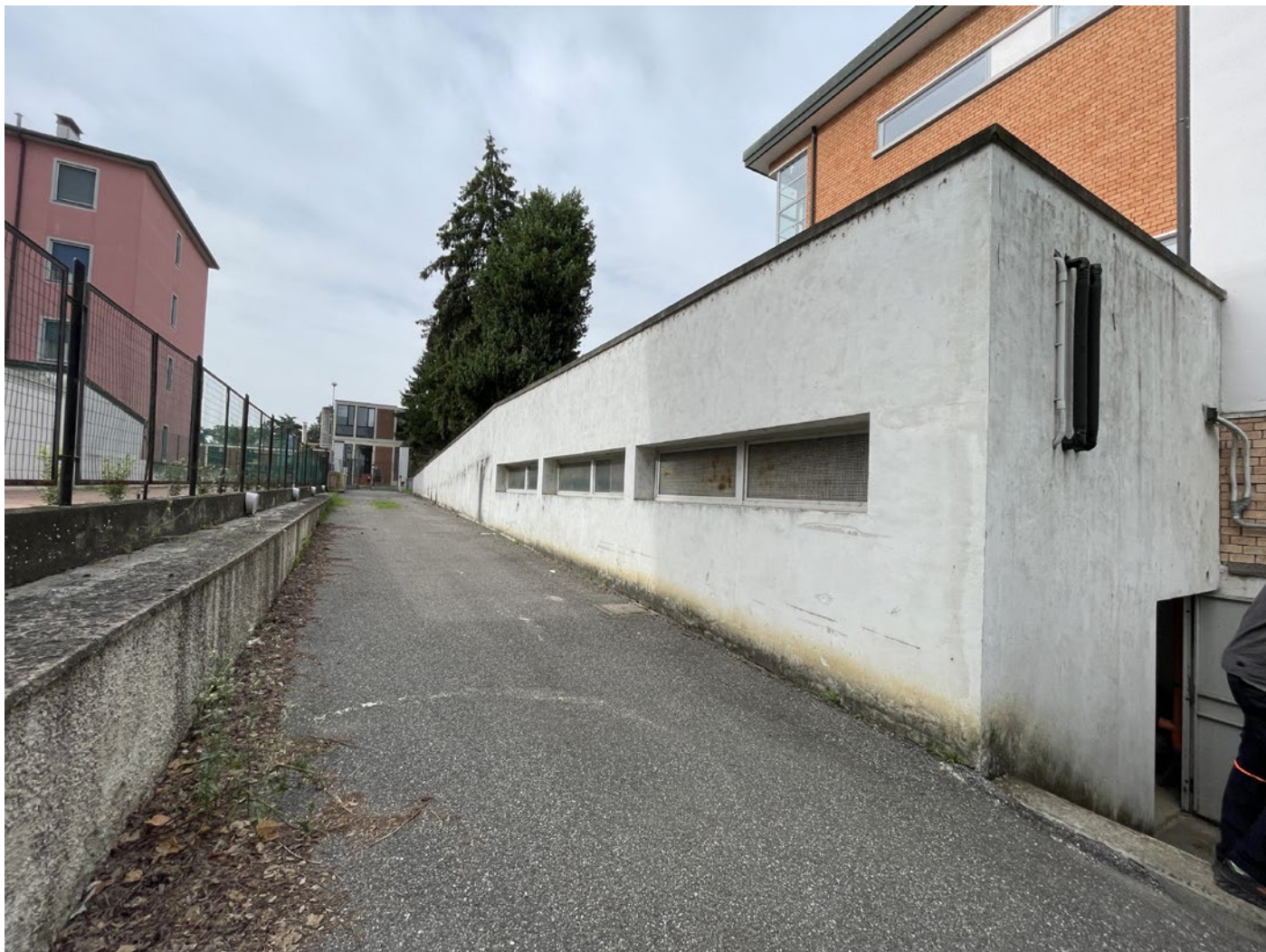
Foto della facciata soggetta a modifica dall'esterno
