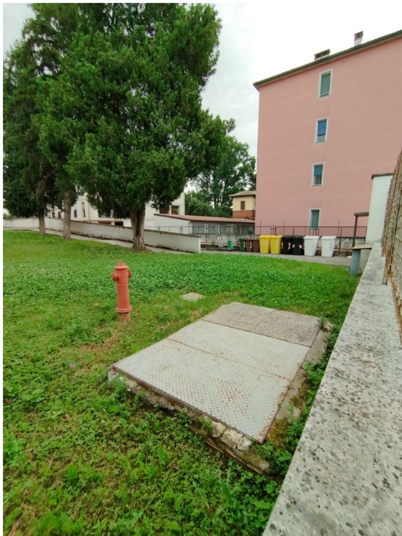
Area esterna del futuro Nido che avrebbe dovuto ospitare il deposito attrezzi. Si vedono l'idrante, la zona contatori acqua all'interno di una botola carrabile a pavimento e in lontananza il vano contatori che deve essere ampliato.
