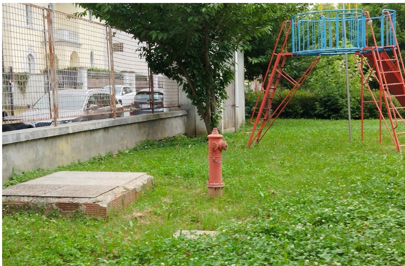
Area esterna del futuro Nido che avrebbe dovuto ospitare il deposito attrezzi. Si vedono l'idrante, la zona contatori acqua all'interno di una botola carrabile a pavimento e in lontananza il vano contatori che deve essere ampliato.
