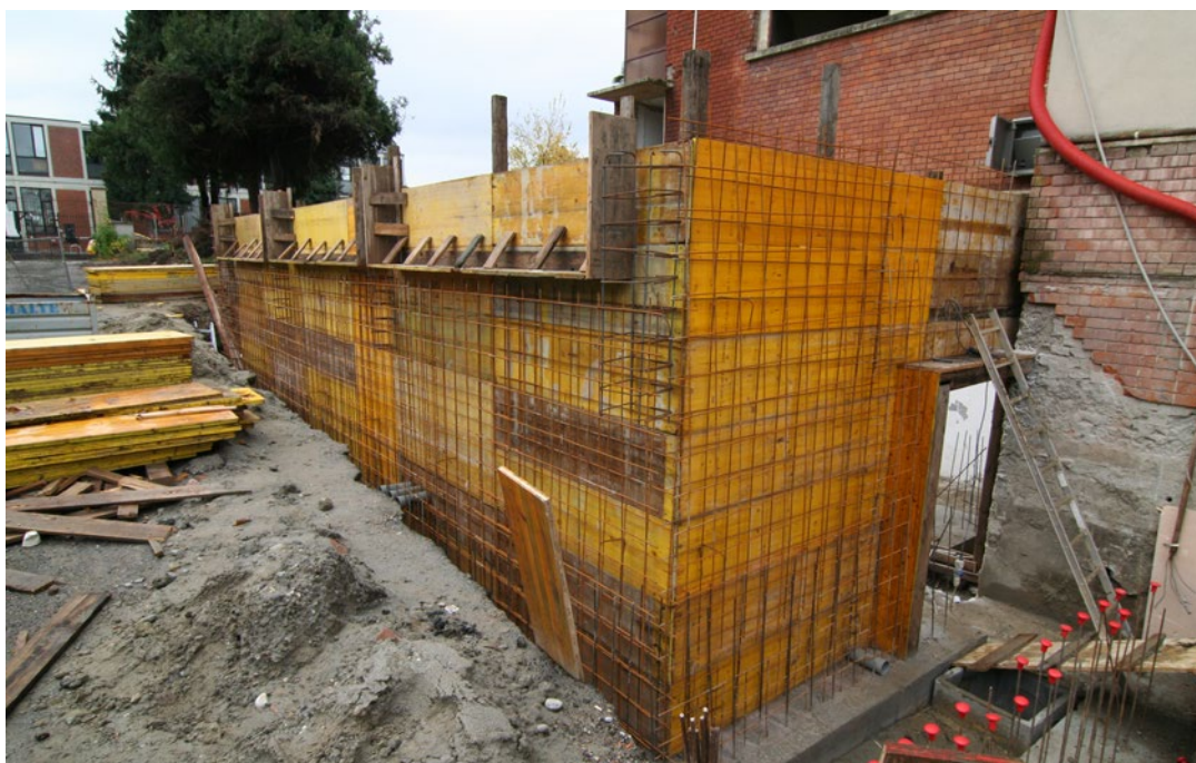
Foto di cantiere dell'intervento del 2014
