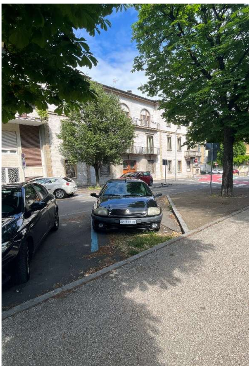
Viale Quattro Novembre – costipamento terreno e danni al colletto
