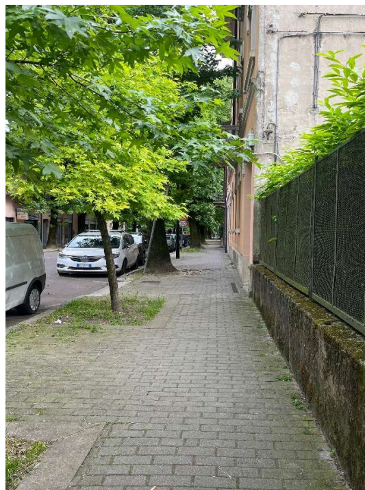
Via Delle Rimembranze – sollevamento della pavimentazione autobloccante
