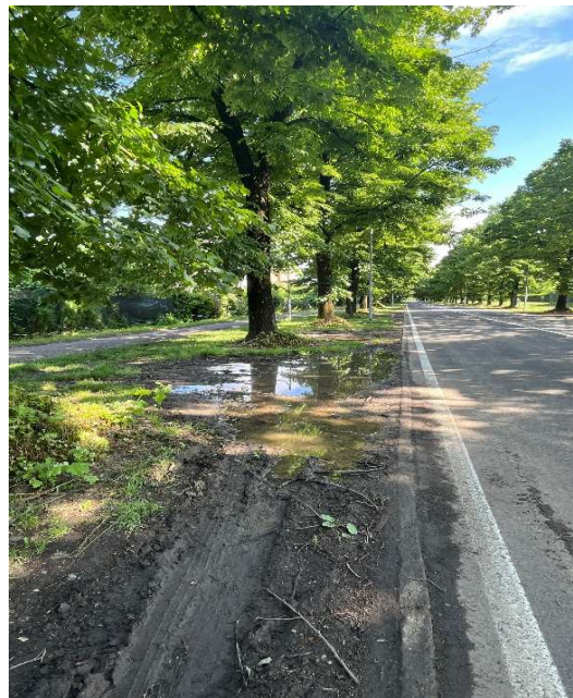
Via Piermarini – ristagno idrico
