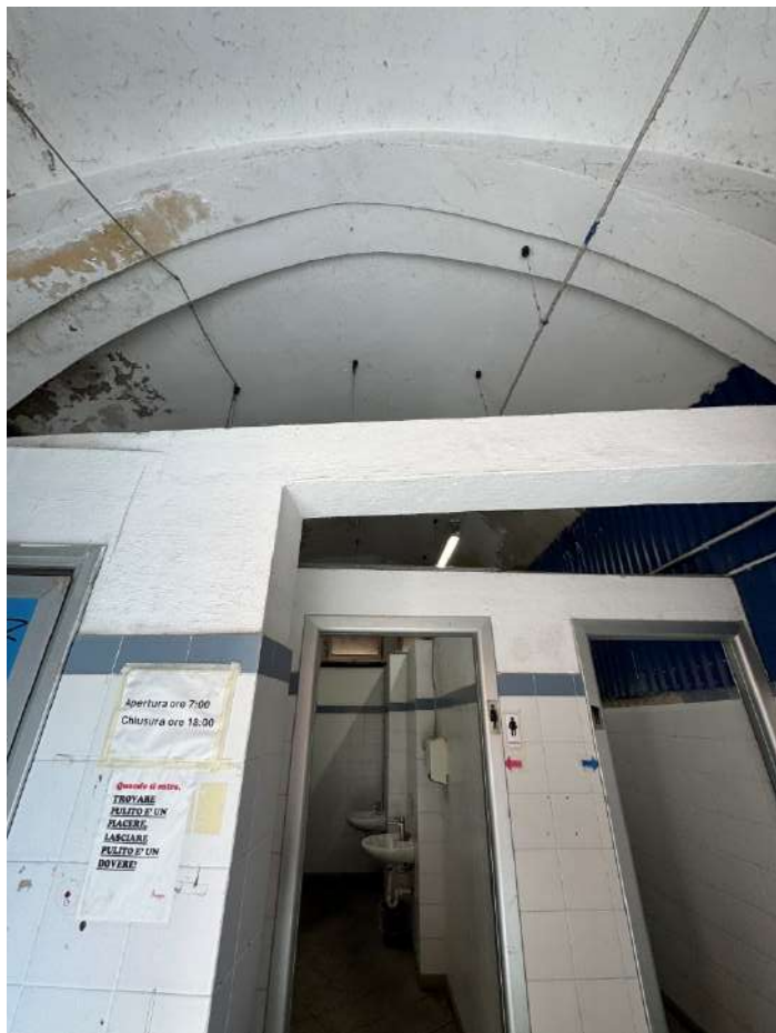
Vista soffitto d'ingresso
