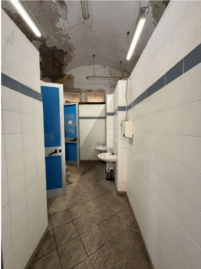
Vista interna settore donne
