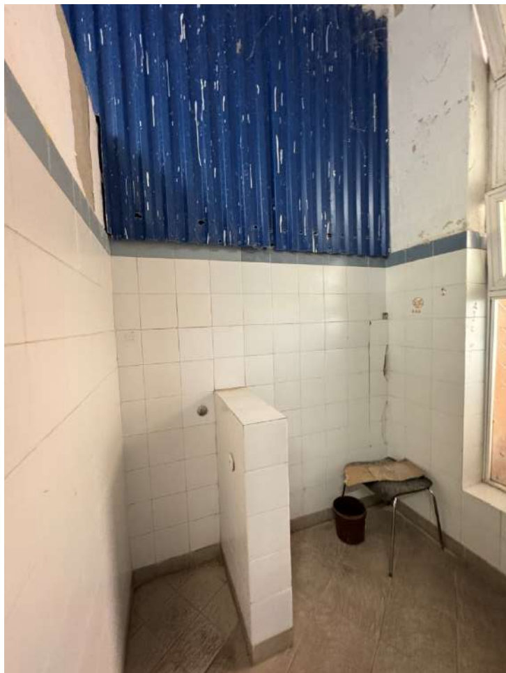
Vista interna_ i materiali di finitura: pavimenti e rivestimenti
