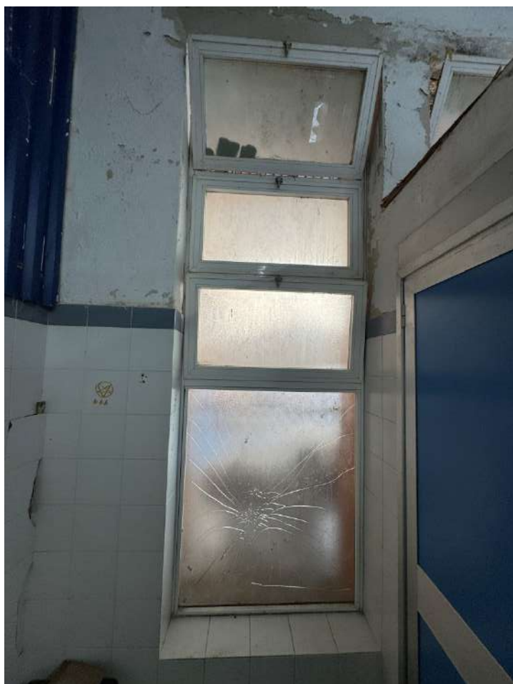
Vista interna_ i materiali di finitura :serramenti esterni
