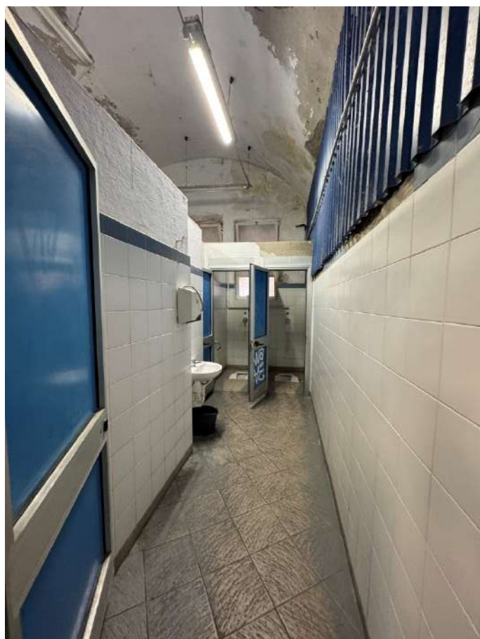
Vista interna settore uomini
