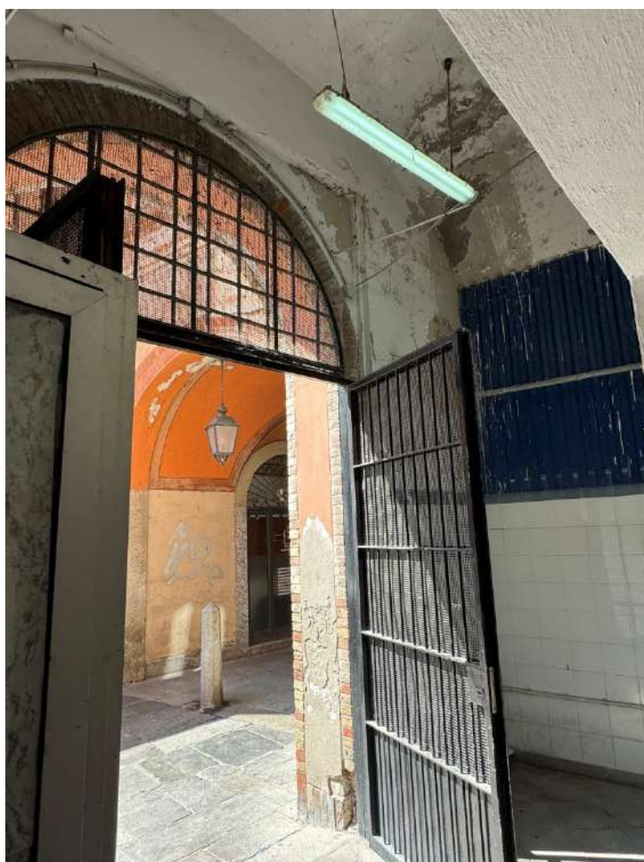
Vista del cancello d'ingresso
