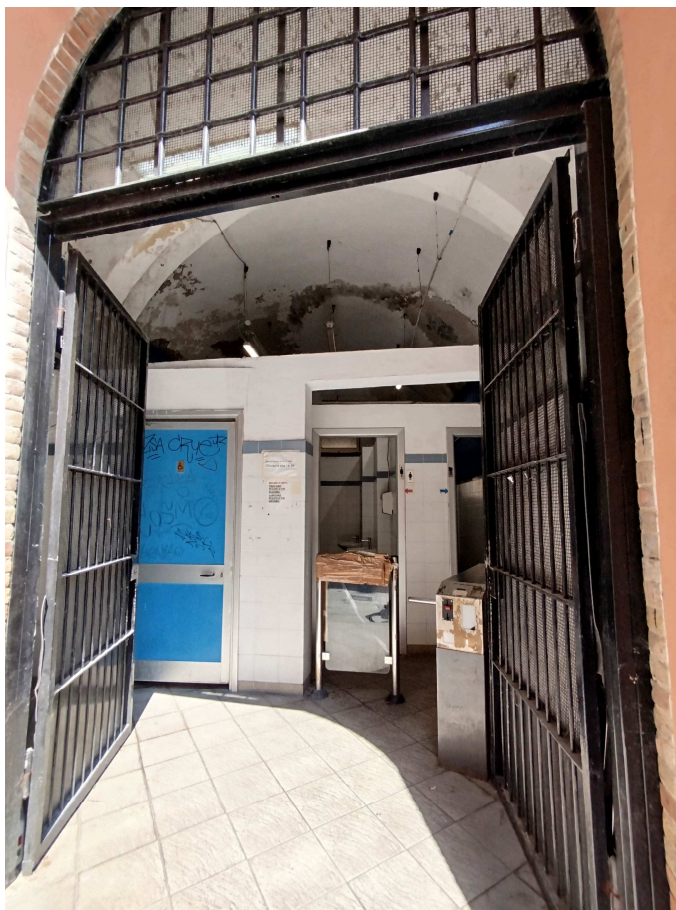
Vista dell'area di cantiere
