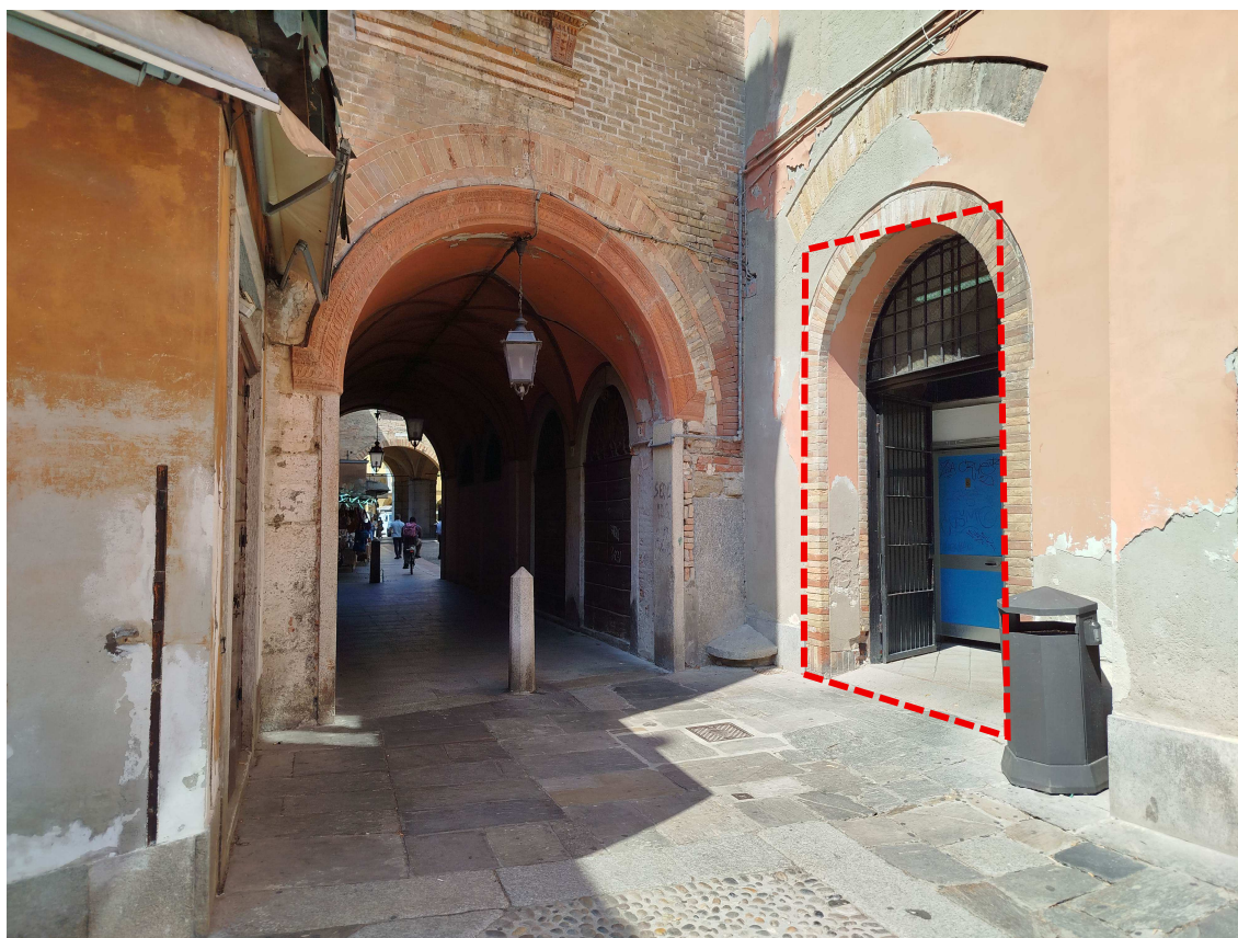
Vista ingresso al cantiere ( - - - - - ingresso cantiere)
