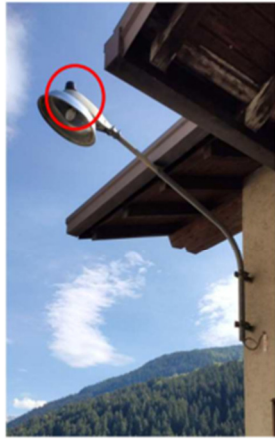
Monocellula su mensola installata direttamente a parete
