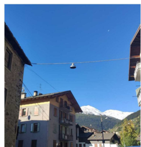
Tesata che porta la bassa tensione
