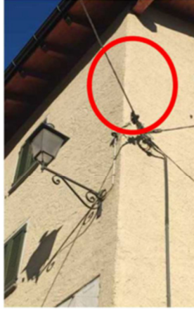
Monocellula su mensola installata direttamente a parete
