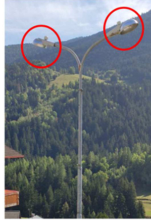
Monocellula su palo con linea interrata o comunque senza linea di distribuzione
