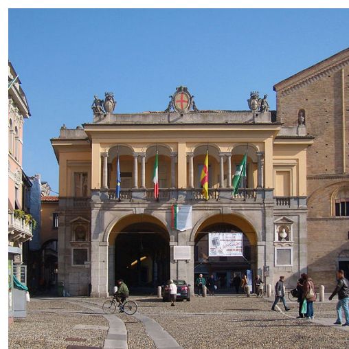
2. Facciata principale del Palazzo del Broletto
