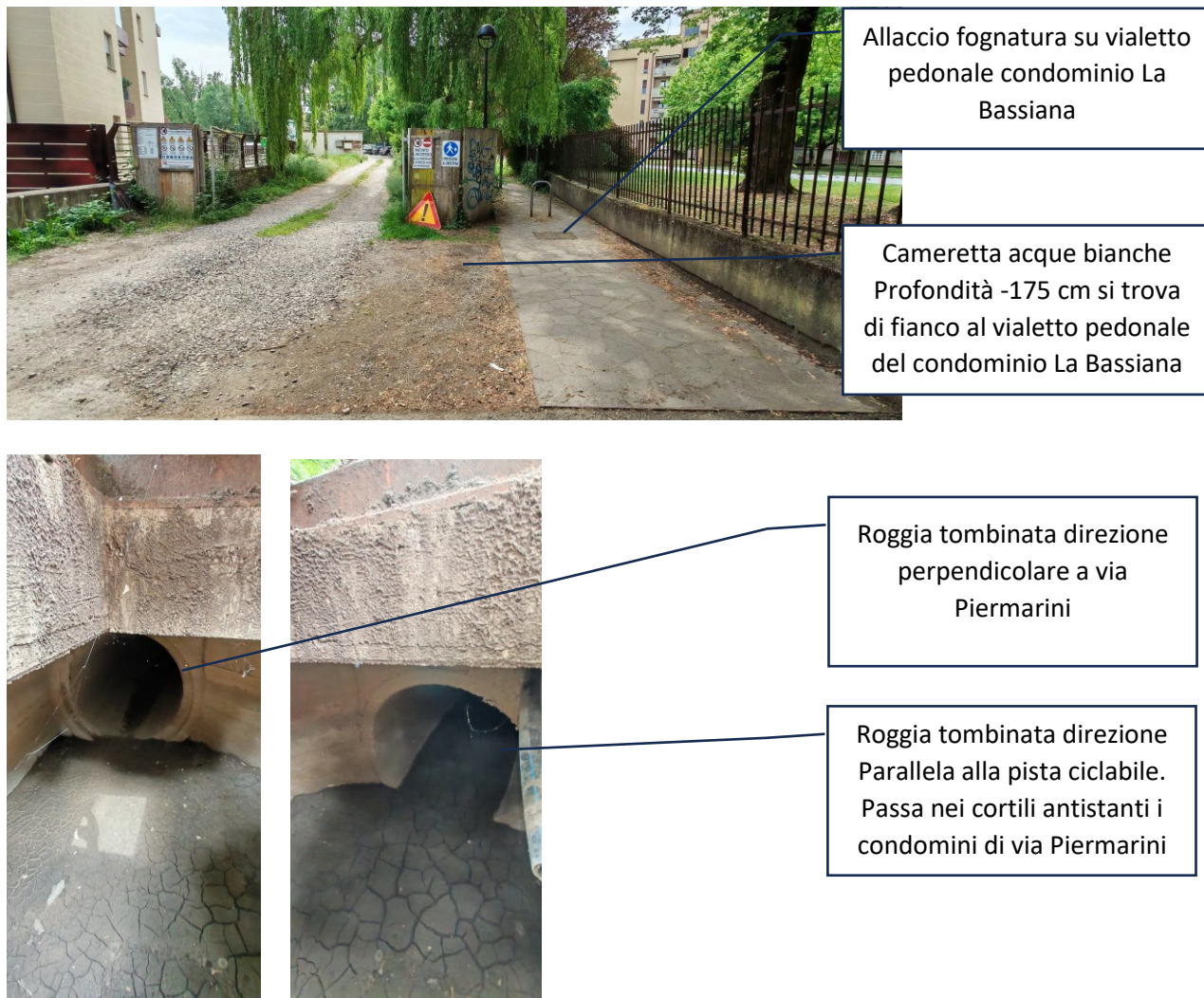
Figura 7: Roggia Cassinetta, attraversamento perpendicolare a via Piermarini
